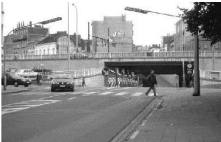
Fig. 76 Attraversamento pedonale illuminato (54).
