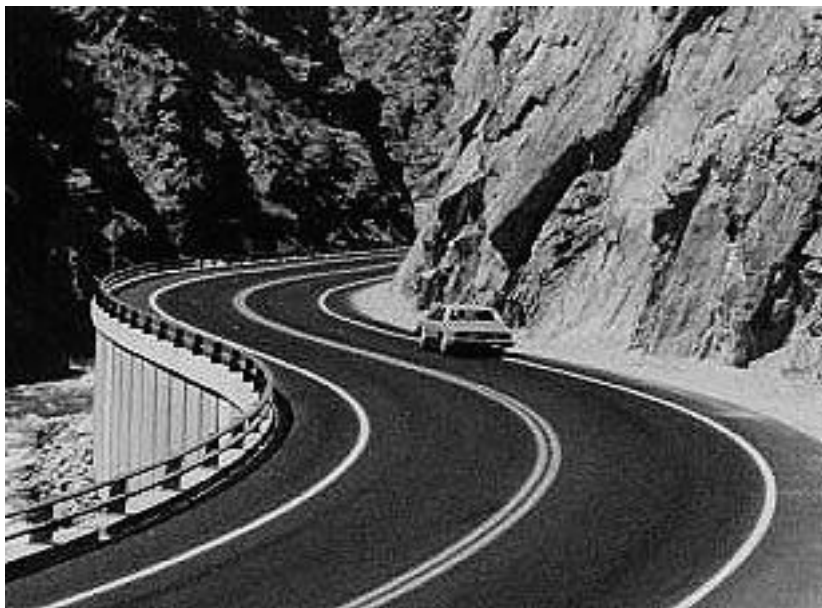
Fig. 86 Sito con fuoriuscita ad elevata pericolosità.
